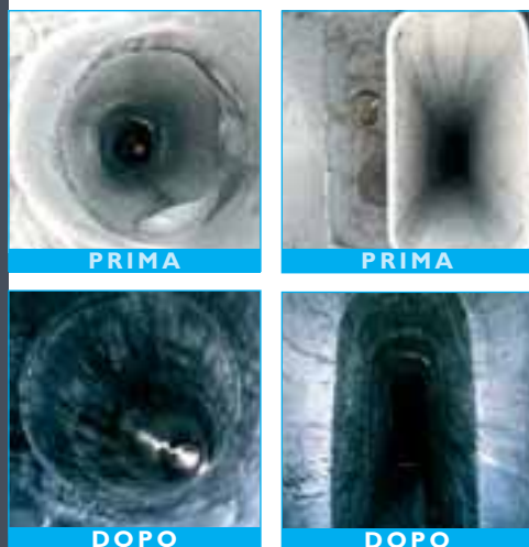
Esempi di installazione della manichetta FuranFlex®
